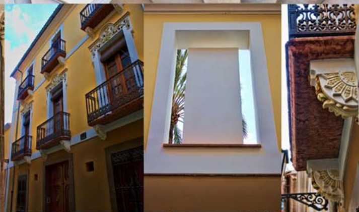
CASA "FRANCIS" CASCO HISTÓRICO-REHABILITACIÓN DE VIVIENDAS ENTRE MEDIANERAS Villena, Alicante 2.002-2.003
