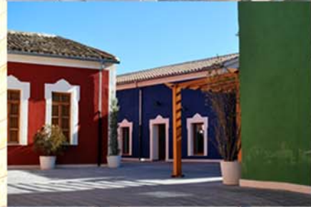
REHABILITACIÓN EDIFICIO DE LA TERCIA
