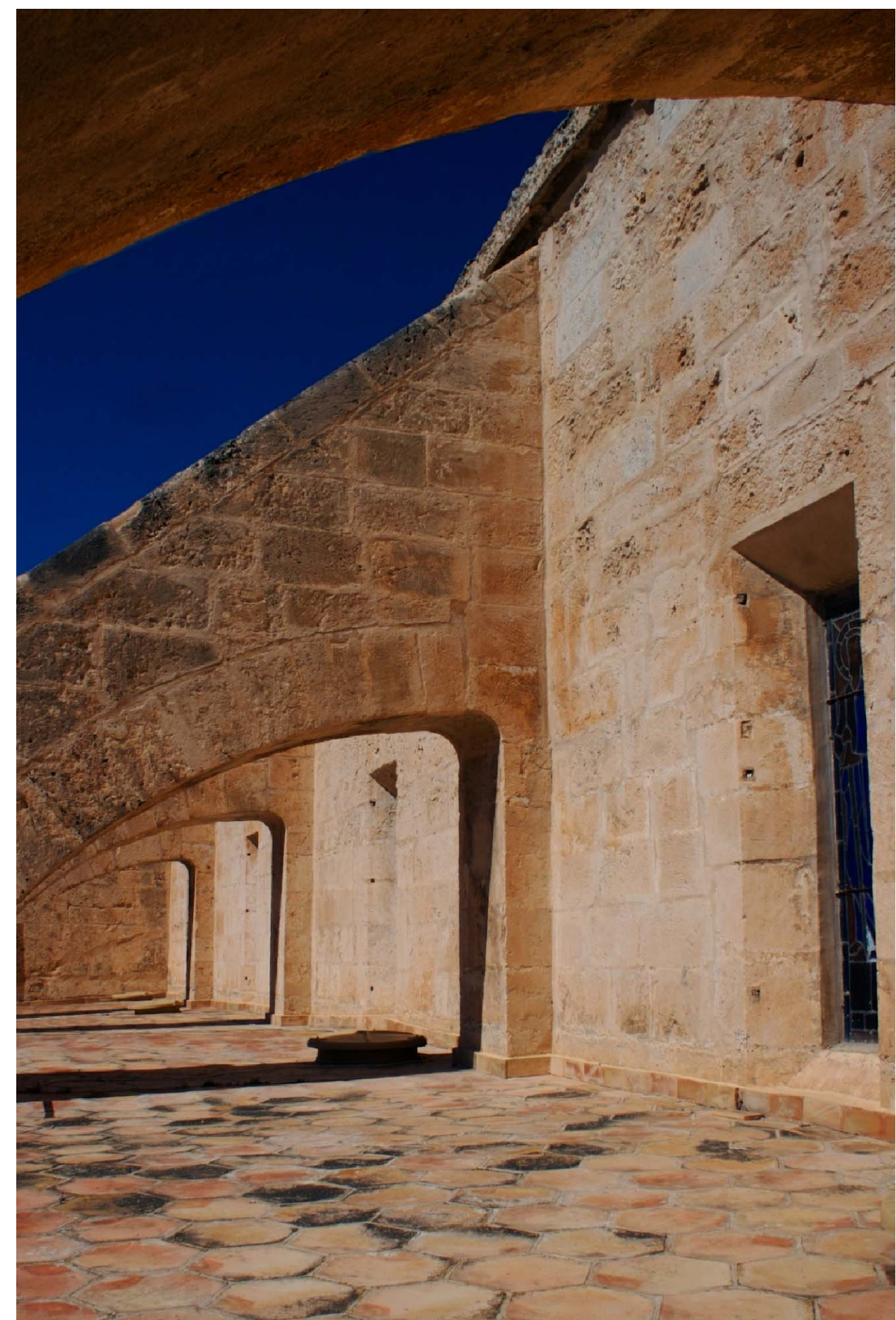
Contrafuertes de la Iglesia
