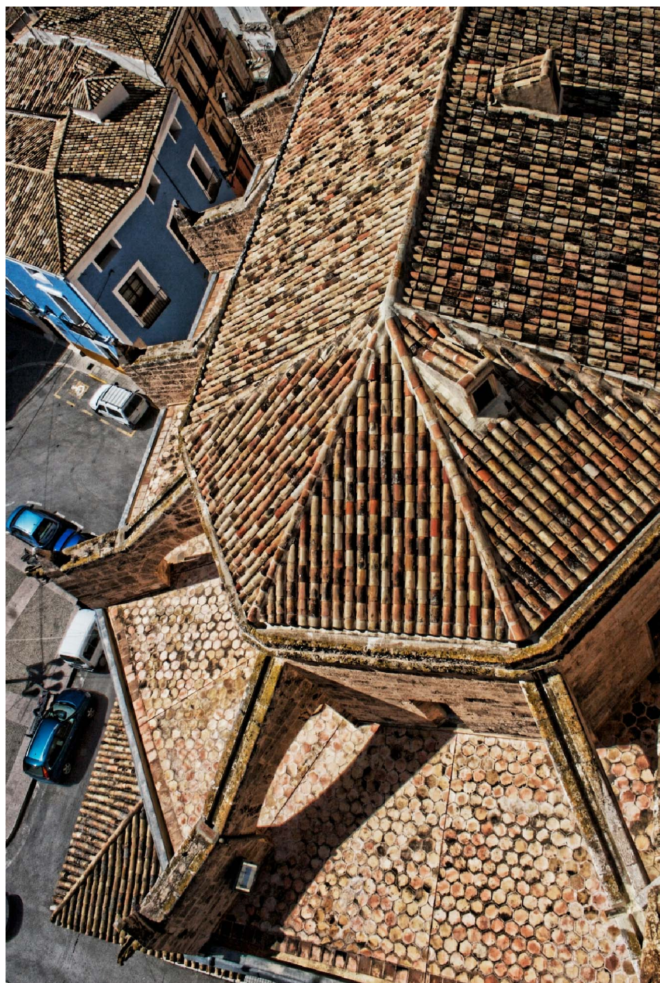
Cubierta de la nave central
