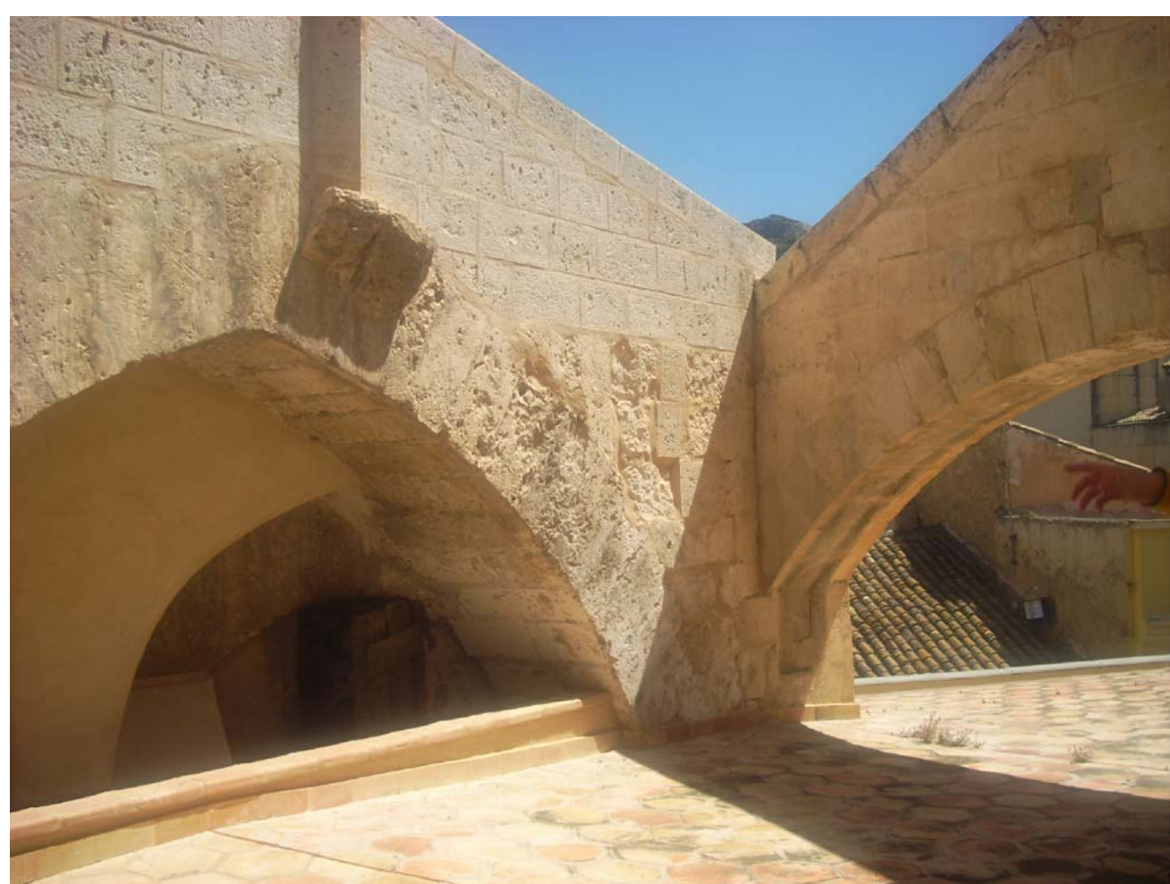
Encuentro de contrafuertes
